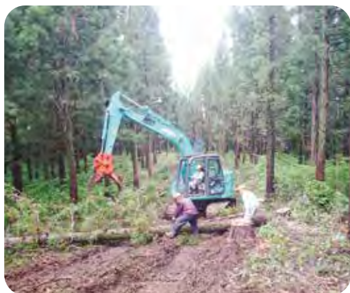
林業専用道開設の支障木伐採
